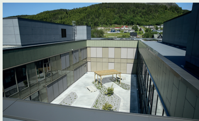
Eidet skule er bygget i en firkant med et uteområde i midten.
